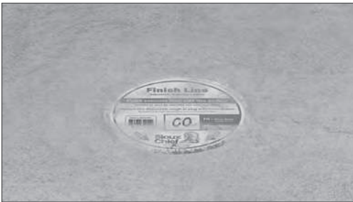
Pour Concrete Flush with Plug
