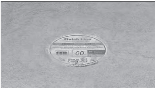
Pour Concrete Flush with Plug
