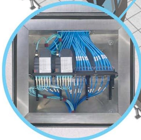
Los sistemas de cableado de cobre y fibra QuickNet™ son compatibles con gabinetes PanZone™ y cajas para aplicaciones de cableado de la zona.
