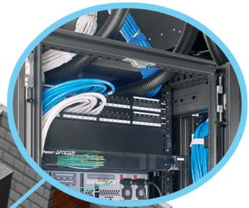
Los casetes QuickNet™ se insertan y liberan de los paneles de parcheo QuickNet™, lo que permite una instalación rápida y confiable en las aplicaciones con servidor.
