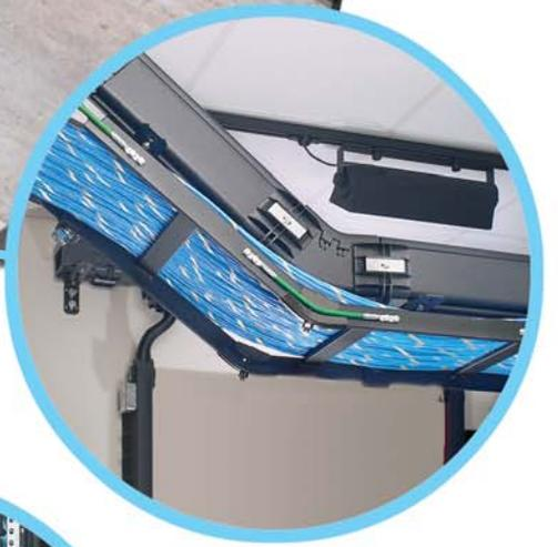
Los ensambles de cables en mazos QuickNet™ se enrutan fácilmente en el de enrutado de canal superior Wyr-Grid™, en el sistema de enrutado de cables FiberRunner™ o en el sistema de enrutado de cables en pisos falsos GridRunner™.
