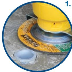
**1.** Cut broken conduit off flush.
