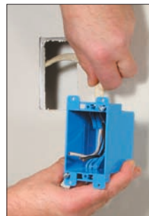
Insert Wires
